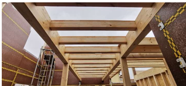
Fig 16. Vivienda piloto del proyecto LIFE WOOD FOR FUTURE que incorpora vigas laminadas de madera de chopo de la Vega de Granada
