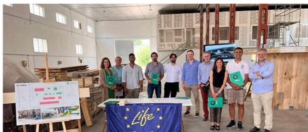
Fig 2. Visita del Director General de Política Forestal y Biodiversidad de la Junta de Andalucía a las obras de adecuación de la primera nave de la Azucarera de San Isidro.
