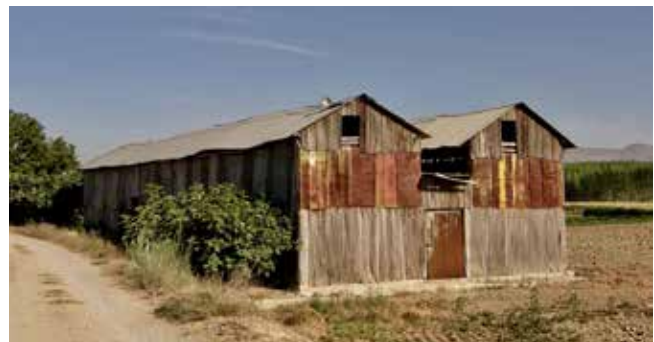
Envolvente mixta de madera y chapa. Secaderos con acceso común en uno de los caminos de Fuente Vaqueros. Granada. García Nofuentes, 2017.
