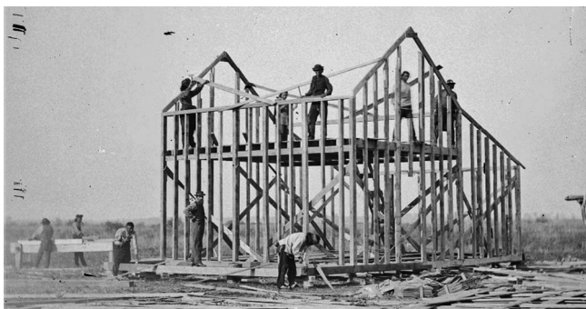
Figura 3: Estructura de entramado ligero de madera durante el siglo XIX en Estados Unidos (Fuente: https://www.hogarmadera.com/beautiful-lighting-effects/ ).
