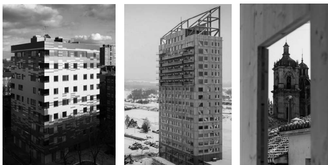
Figura 6: Edificios de CLT. Izquierda: Murray Grove, Londres (9 plantas). Centro: Mjøstårnet, Noruega (86 m). Derecha: Residencial en Calle Cuenca (Bonsai Arquitectos), Granada (planta baja, 3 plantas y ático; Foto: Bonsai Arquitectos / Ádám Tóth).
