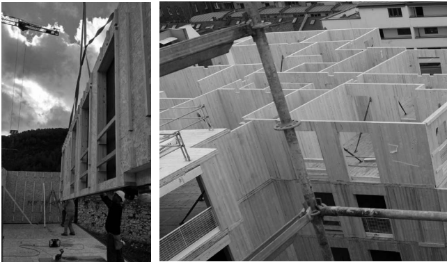
Figura 5: Izquierda: Colocación en obra de una fachada de entramado ligero hecha en la industria (Fuente: Arquigreen. Dña. Ana Carvajal). Derecha: Montaje en obra de los muros interiores y de fachada de un edificio residencial de CLT (Fuente: José A. Lorenzana. PEMADE-Universidad de Santiago de Compostela).
