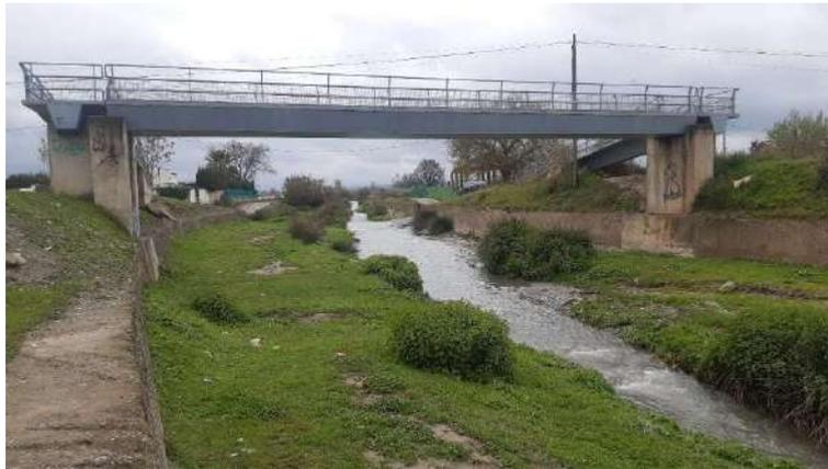
Figura 19. Encauzamiento de muros de hormigón del tramo 10
