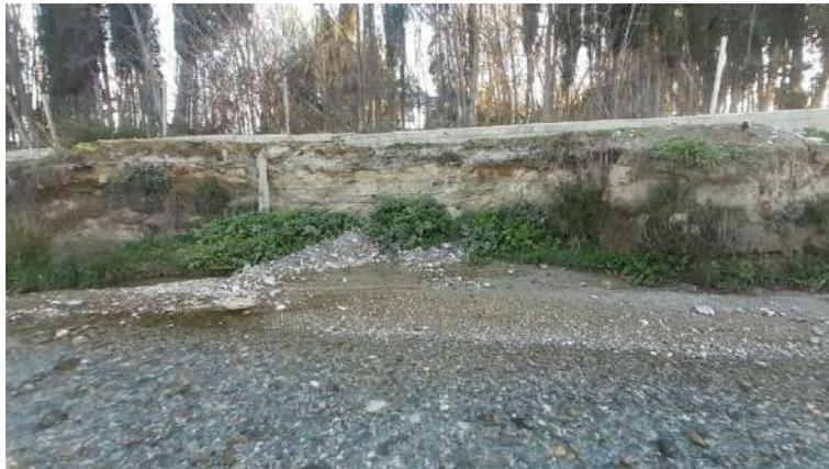
Figura 12. Tramo 3. Muy erosionado y sin vegetación.
